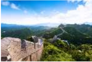
Die Große Mauer
